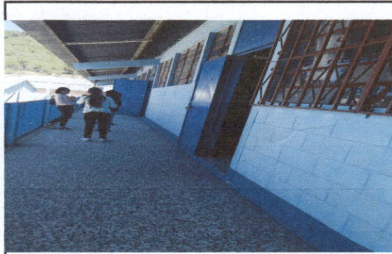
Foto 2: Pintura en muros exteriores e interiores
