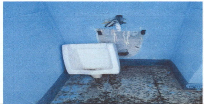
Foto 4: sustitución de migitorio
