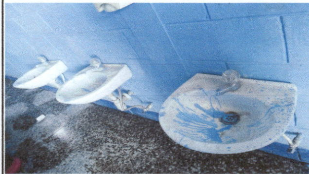
Foto 3: sustirución de lavamanos
