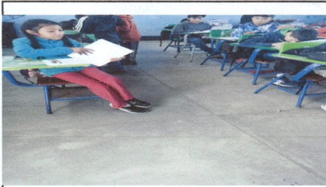
Foto1: Reparación de piso granito.
